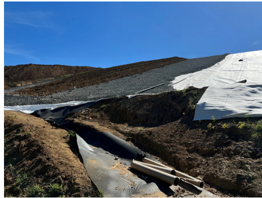
Entwässerungsdrainagen im Hang, Schutzvlies, Entwässerungsschicht
