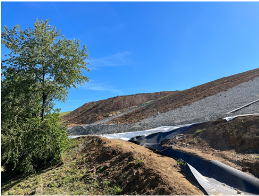
Entwässerungsdrainagen im Hang, Schutzvlies, Entwässerungsschicht
