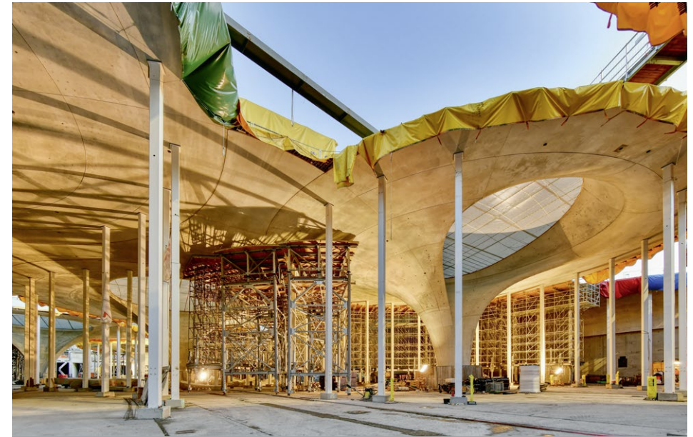
28 Kelchstützen sind das architektonische Highlight des neuen Bahnhofs. Seit Ende 2020 sind sie erstmals begehbar.
